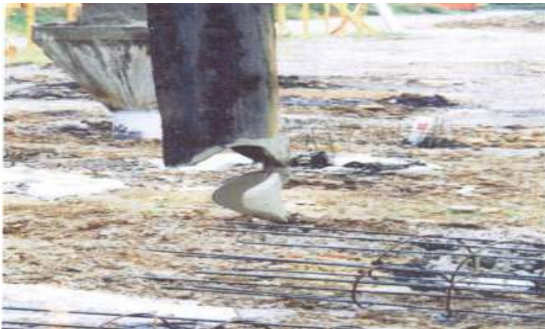
Foto 3: Esempio di valvola apribile per esecuzione pali duplex
