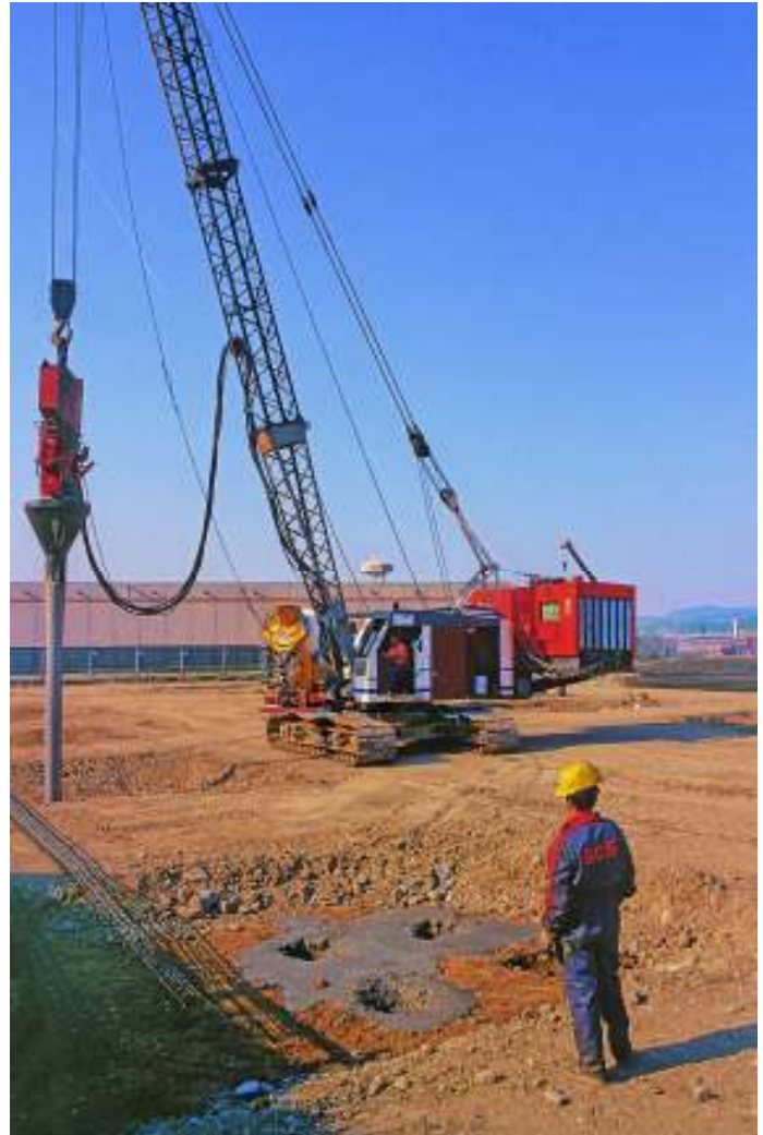
Foto 2: Gru cingolata Link Belt LS 108B c vibroinfessore ad alta frequenza PTC 23 HF
