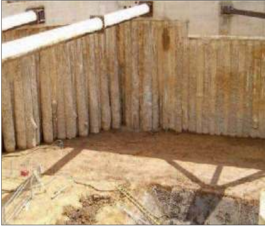
Nella foto si nota la differenza tra pali realizzati con metodologia c.f.a.(a sinistra) e con metodologia c.a.p. (a destra).
