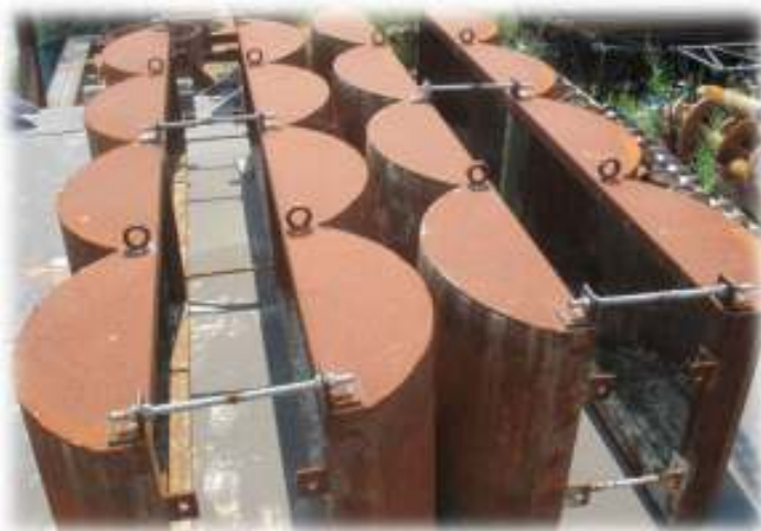
Fig. 4: Casseri metallici per la costruzione delle corree di guida.
