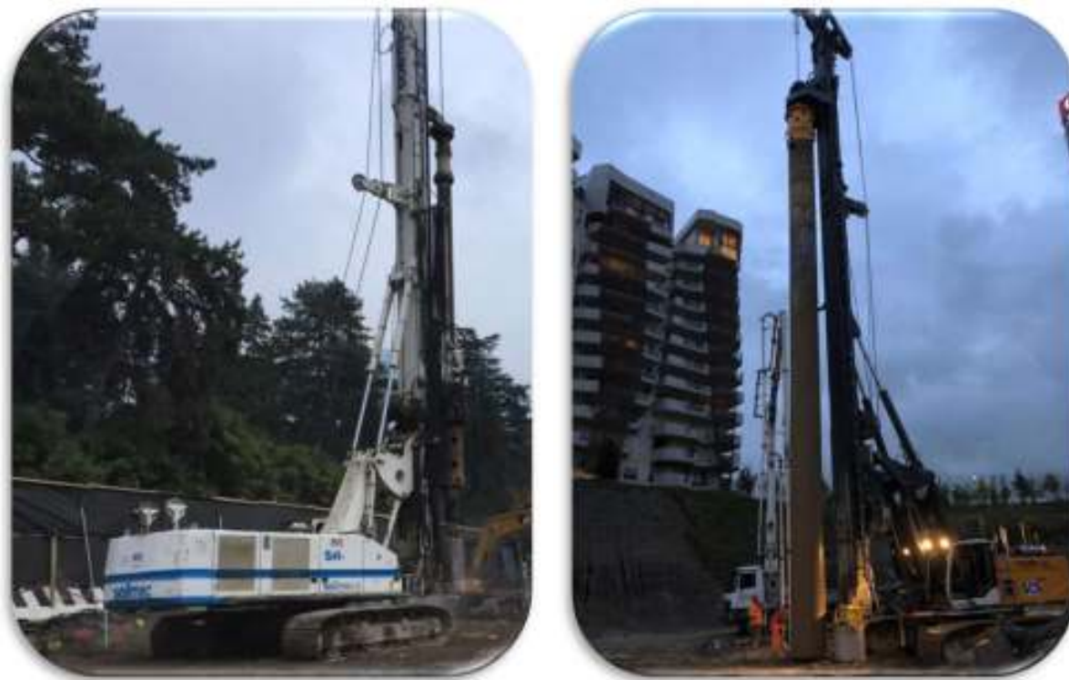
Fig. 3: Perforatrici idrauliche a singola rotary in uso alla scrivente SCS per la realizzazione di paratie di pali C.S.P. (a sx, Soilmec SR-70, a dx Liebherr LB-28-320).
