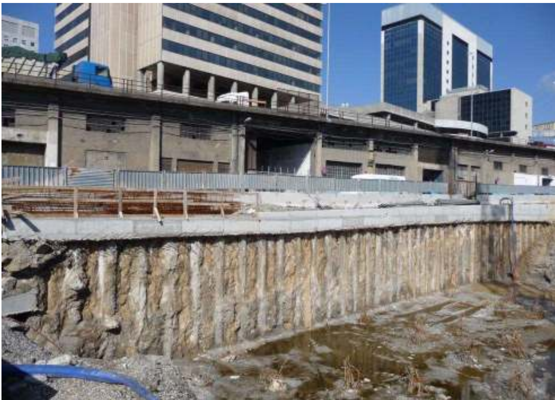
Nella foto si nota la differenza tra pali realizzati con metodologia c.f.a.(a sinistra) e con metodologia c.a.p. (a destra).
