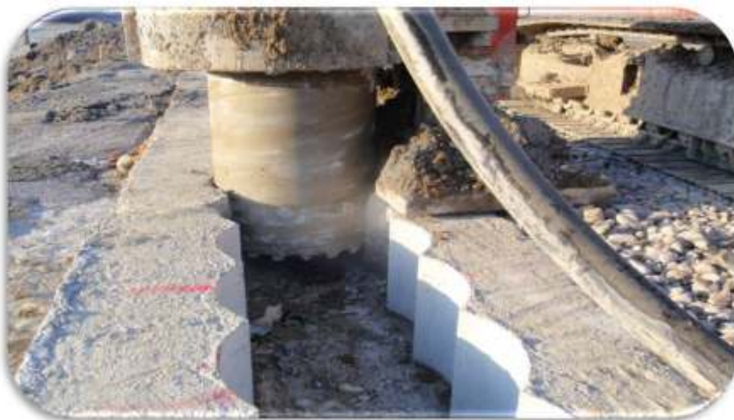
Fig. 2: Correa di guida per la successiva perforazione di pali C.S.P.
